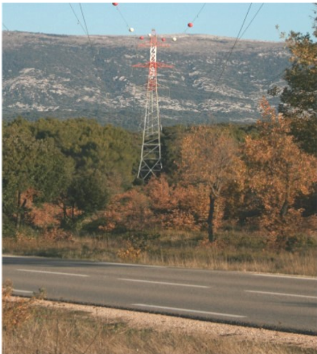
Superposition entre linéaires : route et ligne électriques
